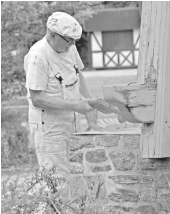
Heimatfreund Lachnitt bei der Arbeit. Gut zu erkennen sind die Schäden am Holz.
