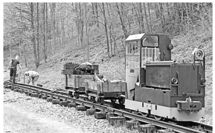
Gleisbau an der Feldbahn
