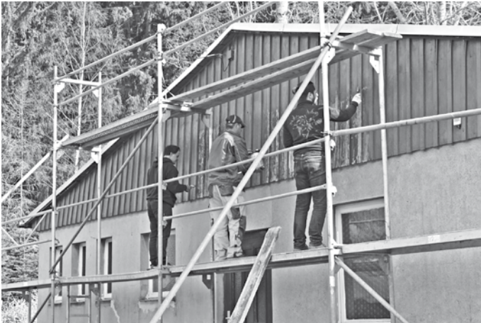
Der Giebel der Badbaracke erhielt einen neuen Anstrich
