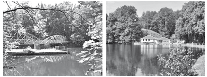
Brücke über die Zwickauer Mulde An der „Hölmühle“ – Gondelteich
