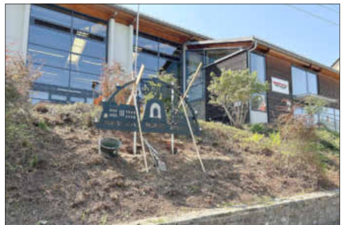
Aufbau des Schwibbogens vor der Sporthalle am 28.08.24
